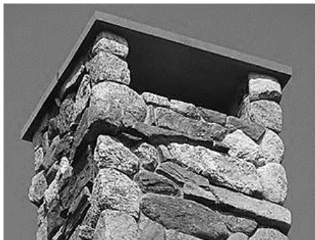
Stone Cap Chimney Top
